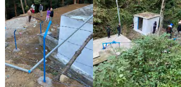
Photos : Captage de la source et station de pompage alimentant le réservoir d'eau pour distribution par gravité (Népal)
