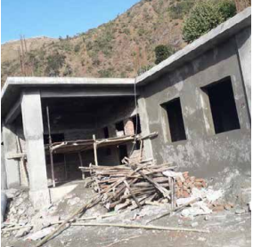
Photo : Construction d'un CHU - Unité de santé communautaire (Népal).
