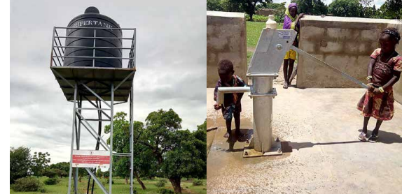
Photos : À gauche, château d'eau pour alimenter les points d'eau destinés à la population (Burkina Faso). À droite, enfants actionnant une pompe dans une école (Burkina Faso).
