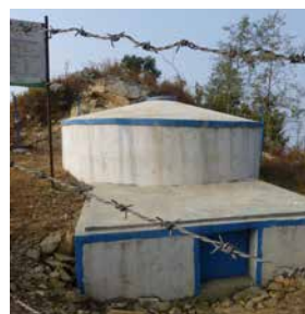
Photo: Construction d'un réservoir d'eau potable type
