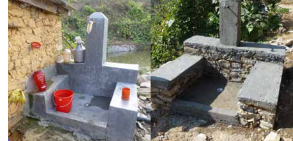
Photo: Construction d'un point d'eau
