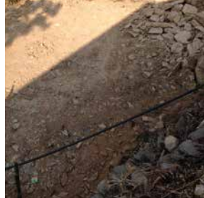
Photo: Terrassement avant construction
