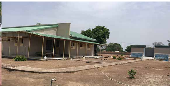
Photo 3: Dispensaire Kounkané avec un bloc WC/douche à droite (Sénégal)
