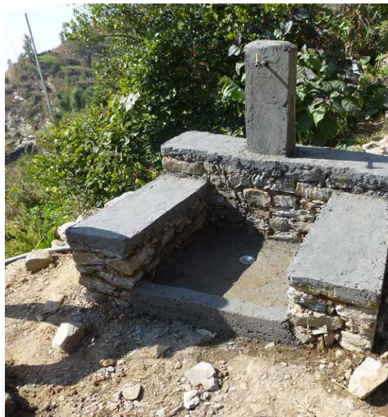
Photo : construction des points d'eau potable (Népal)
