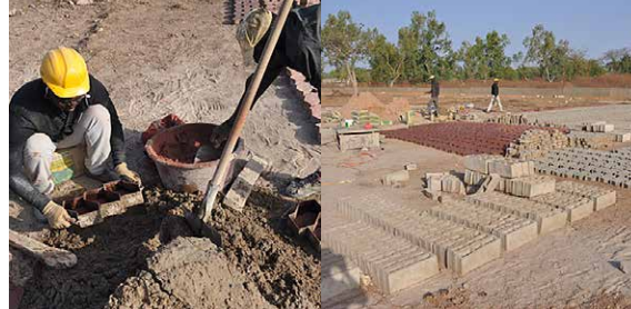
Photos : la fabrication des briques qui sont utilisées pour la construction se fait sur place (Sénégal)
