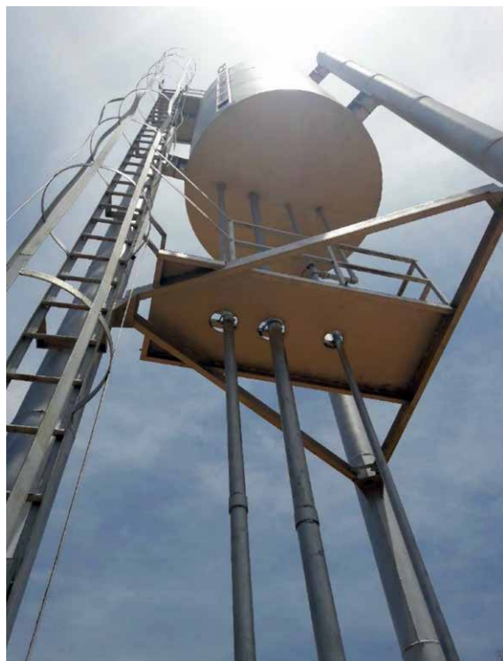
Photo : sécurisation et extension du réseau d'adductions d'eau potable
