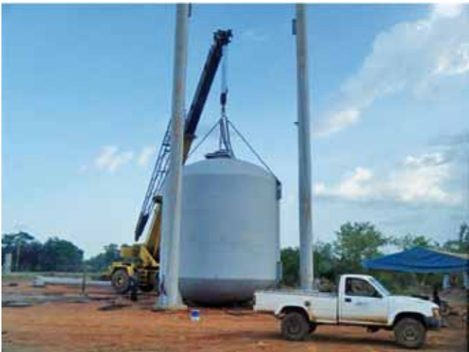
Photo 3 : Installation d'un château d'eau
