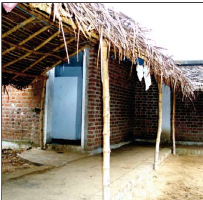
Construction de sanitaires
