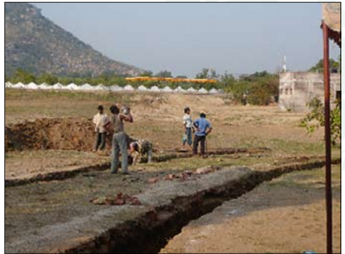
Travaux d'agrandissement du centre médical de Tedjgah
