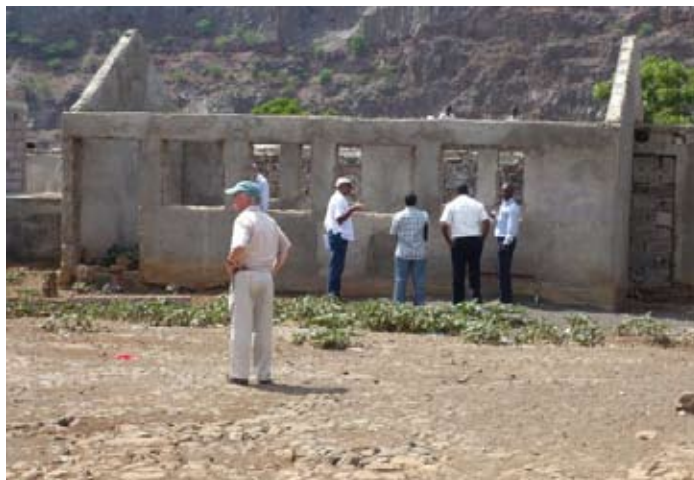
Réfection de l'école primaire de Cha Gonçalves (Praia)
